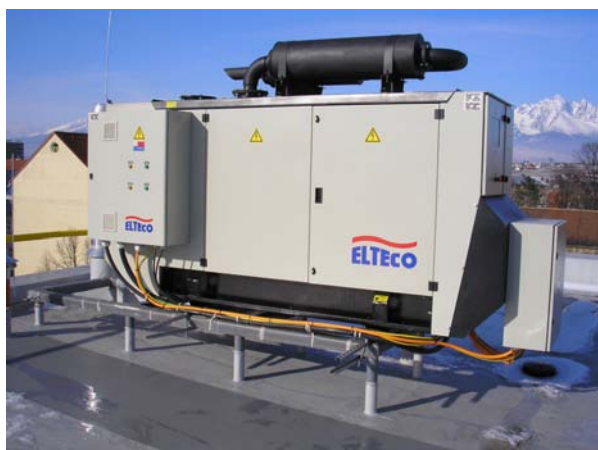
Motorgenerátor 105 kVA
