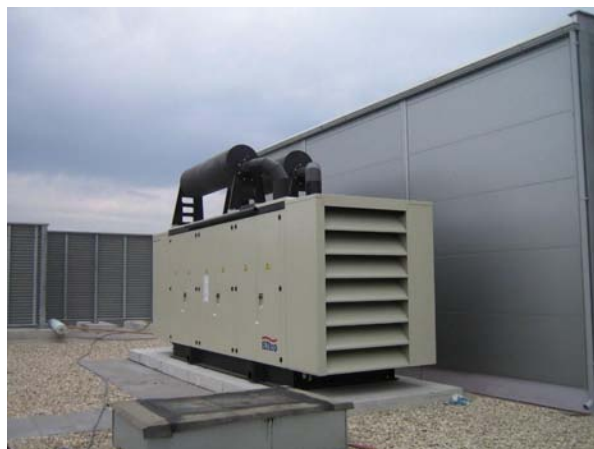
Motorgenerátor 1290 kVA
