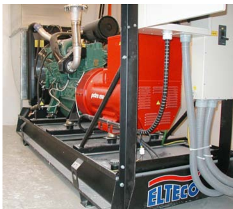
Motorgenerátor 250 kVA
