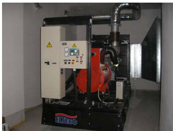
Motorgenerátor 630 kVA
