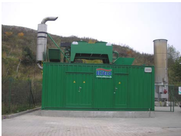
Motorgenerátor 500 kVA
