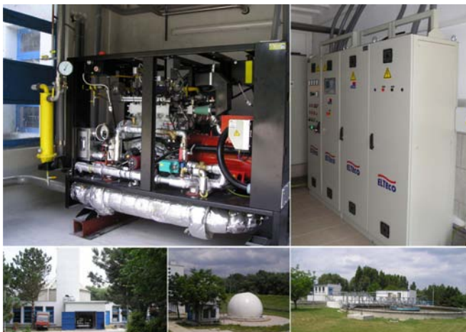
Čistička odpadových vôd Komárno, Slovensko (2008)
