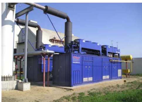
AG Malting plant, Voronezh – Ostrogozh
